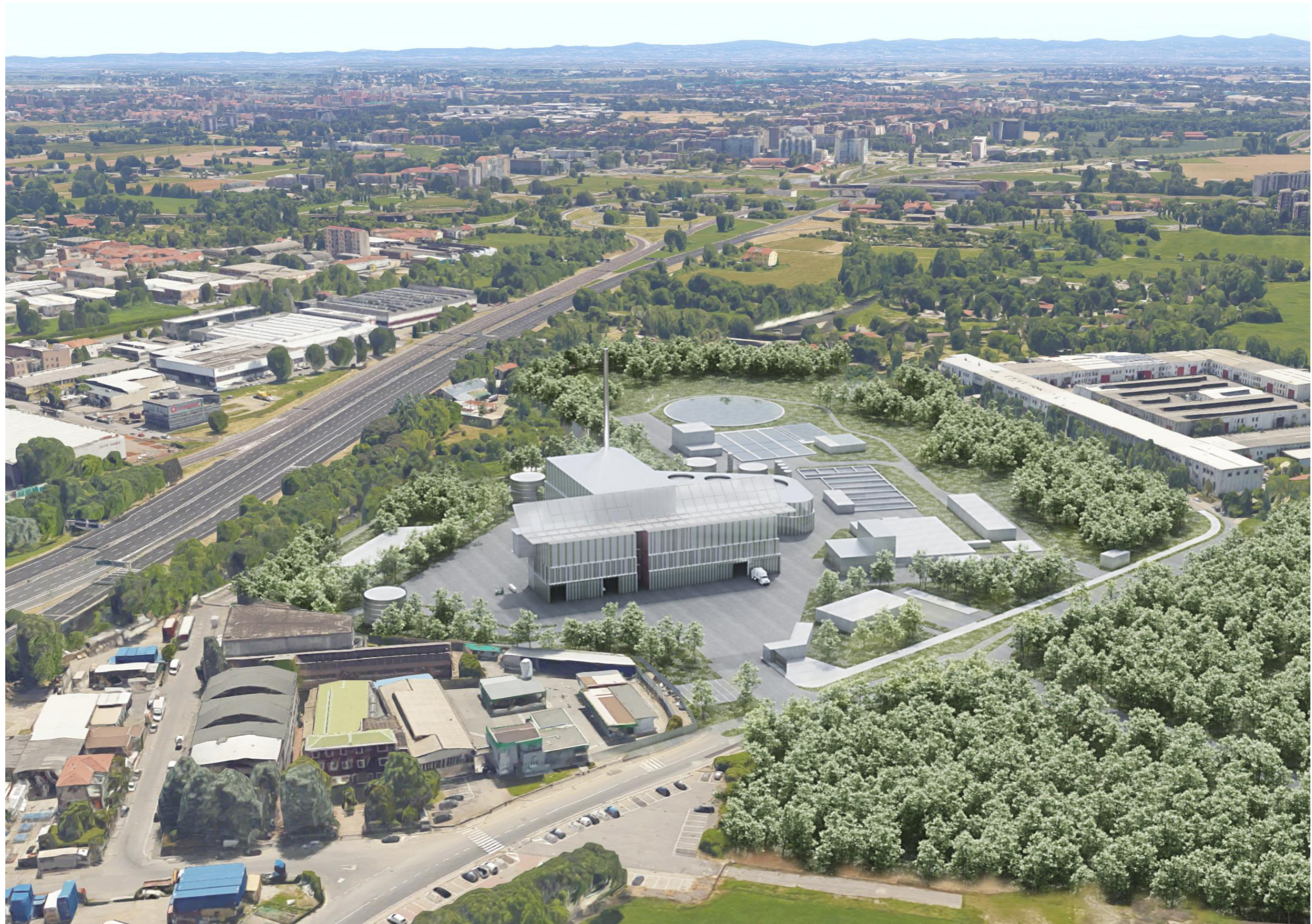
Figura 9 Vista aerea frontale della biopiattaforma
